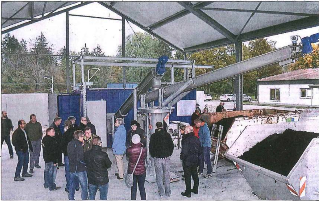
In der neuen Halle fällt aus den Armen der im Hintergrund im Container eingebauten Zentrifuge der entwässerte Klärschlamm in Stahlbehälter. Das 400m 3 fassende Schlammstapelbecken und der dahinterliegende Zentralspeicher sind der Entwässerung vorgeschaltet und machen die drei bisherigen Erdklärbecken überflüssig.
