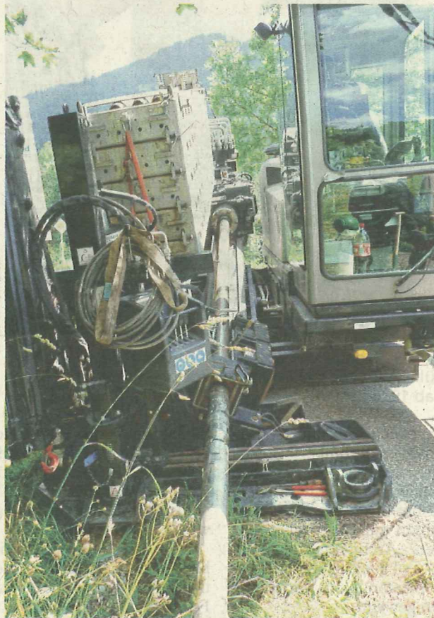
Der Bagger mit dem doppelstängigen Bohrkopf. FOTO ELK
